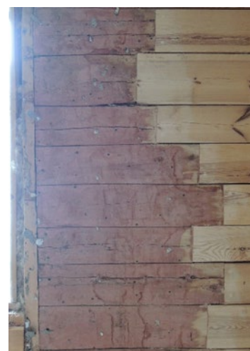
Fig. 49. Limfarge på tømmer vest for vindu på sørvegg.
