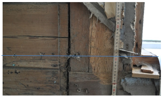
Fig. 86. Lerret og tapet slutter ca 70 cm over dagens gulv. Stifterekke sees i samme høyde.
