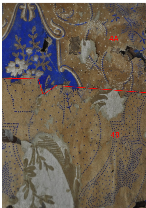
Fig. 31. Tapetlag 4A og 4B. Lag 4B ligger øverst og er påført oppå tidligere pusset brannmursflate.
