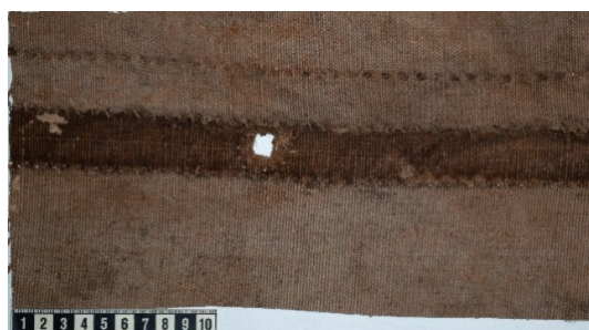
Fig. 18. Umalt lerret med oppsprettete sømmer er strukket på veggen som underlag for lag 2.
