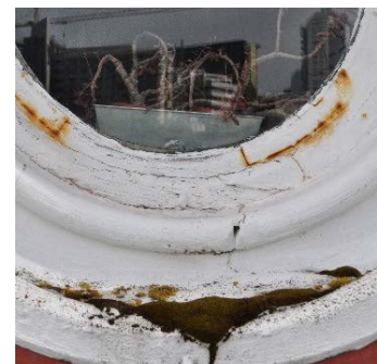
Fig. 16. Rundt vindu på vestfasaden.
