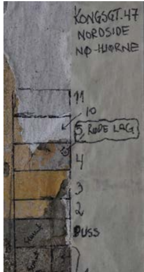
Fig. 34. Fargetrapp inn mot nordøstre hjørne. Avslutningen av hjørnet er pusset i nivå med resten av veggen.
