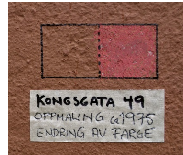
Fig. 20. Lag 8 på bygningens sørvegg. Her sees en markant endring i farge.
