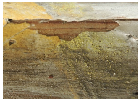
Fig. 26. Kraftig gult sees til høyre på fotoet. Gul oker rankefarge til venstre.
