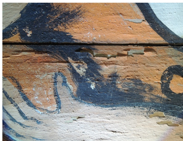
Fig. 37. Utsnittet viser eksempel på skade oppstått som følge av fuktskade i området rundt.
