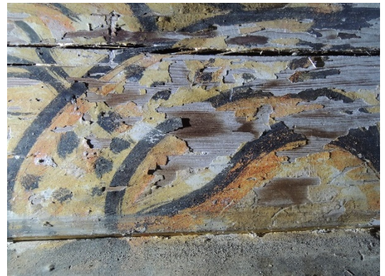
Fig. 40. Opp- og avskallinger i fuktsskadd område på østveggen. Støv og smuss sees på meddraget i nedre kant.
