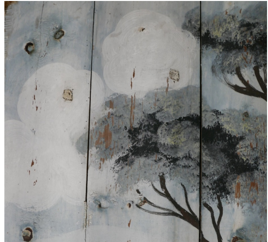
Fig. 17. Detalj fra vestveggen som viser maleteknikken på grener, trekroner og skyformer knyttet til søndre tre.
