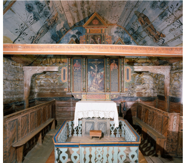
Fig. 3. Østre del med altertavle, Justitia og Charitas og tverrgående bjelke med påskrift før behandling.
