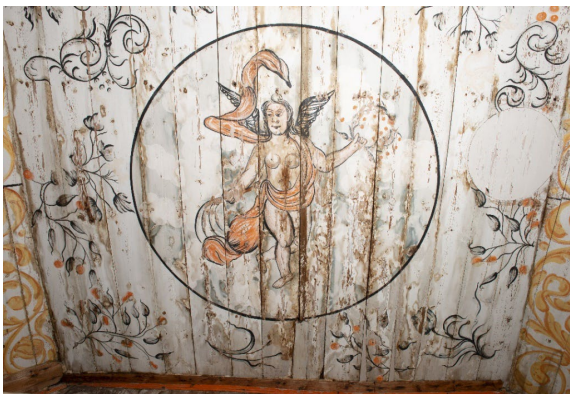
Fig. 9. Himlingens vestre felt. Tidligere pipeløp med innfelt treplate sees til høyre i fotoet.
