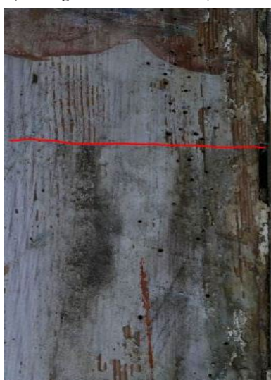
Fig. 65. Vestgavl, nordre side. Detalj under rensing. Partiet over rød markering er punktrenset.
