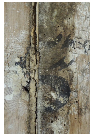
Fig. 42. Detalj fra vestvegg som viser bruk av oljekitt i skipets midtre del. En bokstav ligger i/under kitten.
