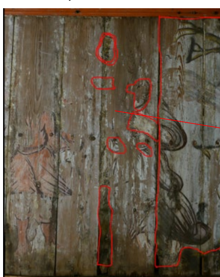
Fig. 66. Vestgavl, nordre side. punktrenset innenfor de røde markeringene.
