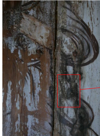
Fig. 53. Vestvegg. Nordre del. Detalj engel. Område med misfarget og svært skitten overflate.
