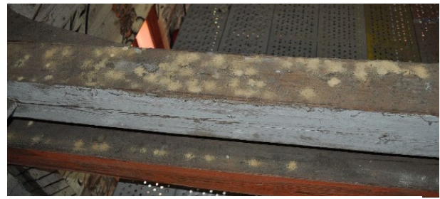
Fig. 58. Tverrgående bjelkepar i midtre del. Tallrike topper med boremel på toppen av bjelkene.
