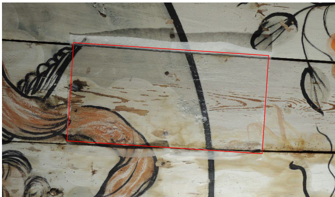
Fig. 60. Detalj fra himlingens vestre felt som viser konsolideringen i prosess med japanpapir og tørkepapir i et panelbords bredde.
