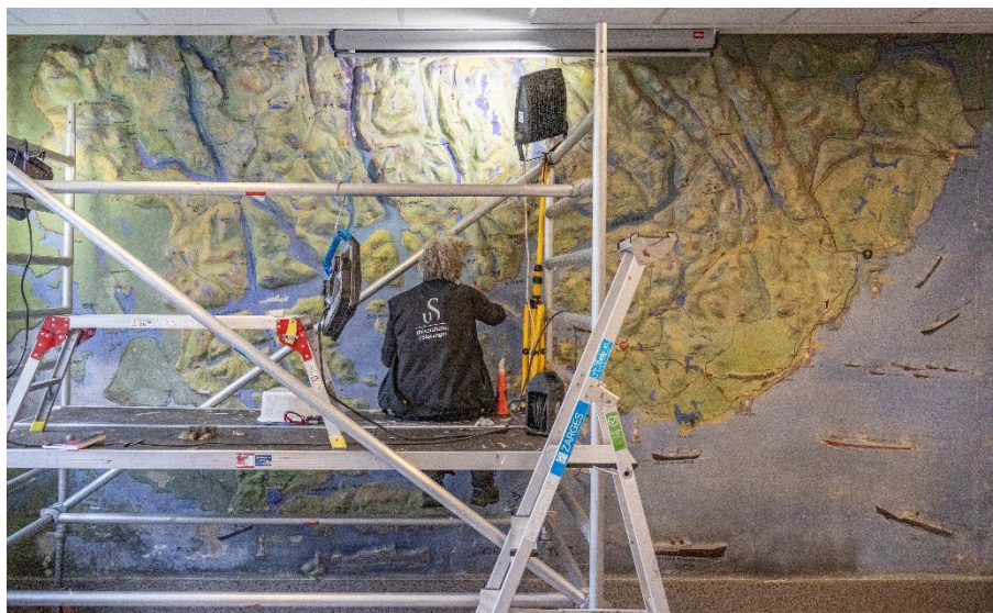
Figur 13) Arbeidsbilde av Ann på stillaset under behandlingen 2023.
