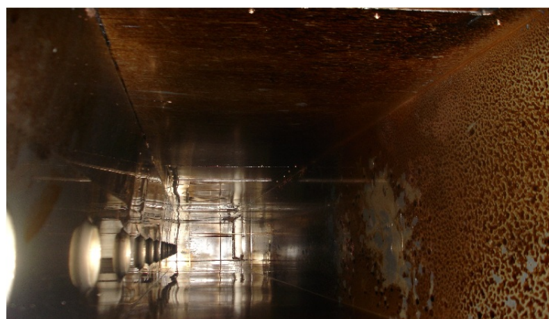
Figur C.6: Røyktjære setter seg rundt i sirkulasjonssystemet.
