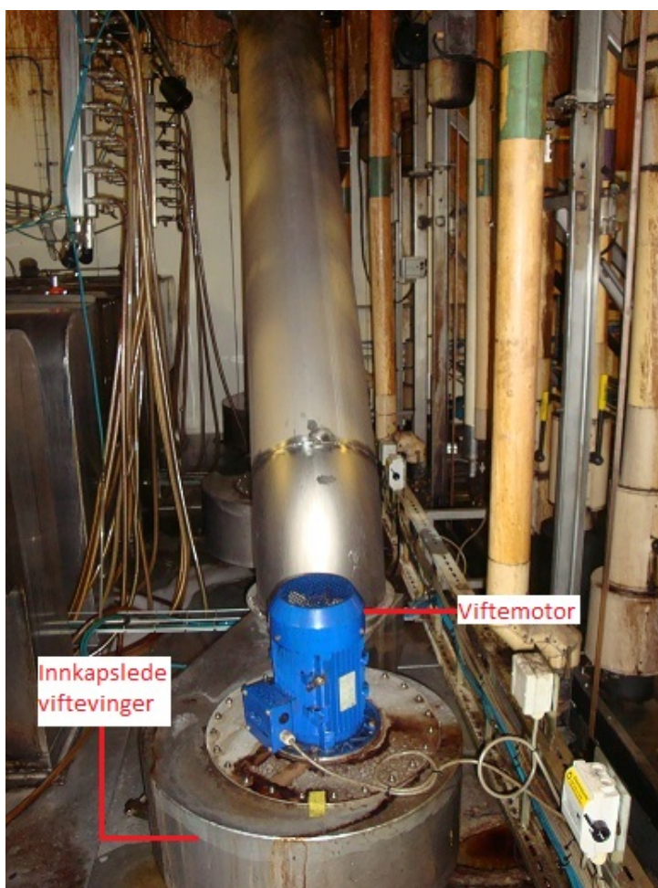
Figur A.3: Det mekaniske avtrekket med innkapslede viftevinger.
