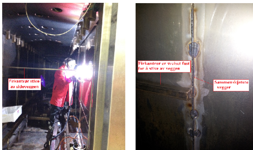
Figur D.1: Oppretting av sideveggene i batchskapet.
