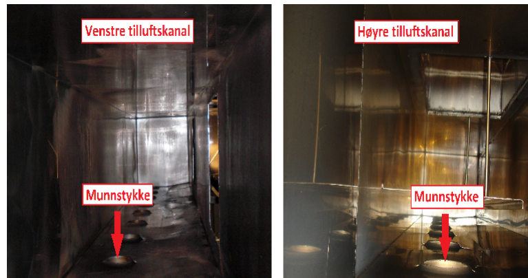
Figur D.5: Resultatet av sirkulasjonssystemet og kanaler etter vaskeprogram.
