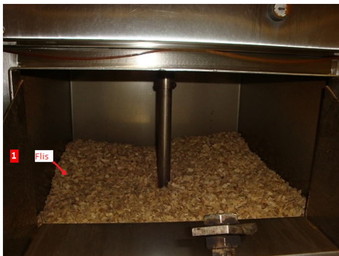
Figur A.7: Rom 1 i røykgeneratorhuset.
