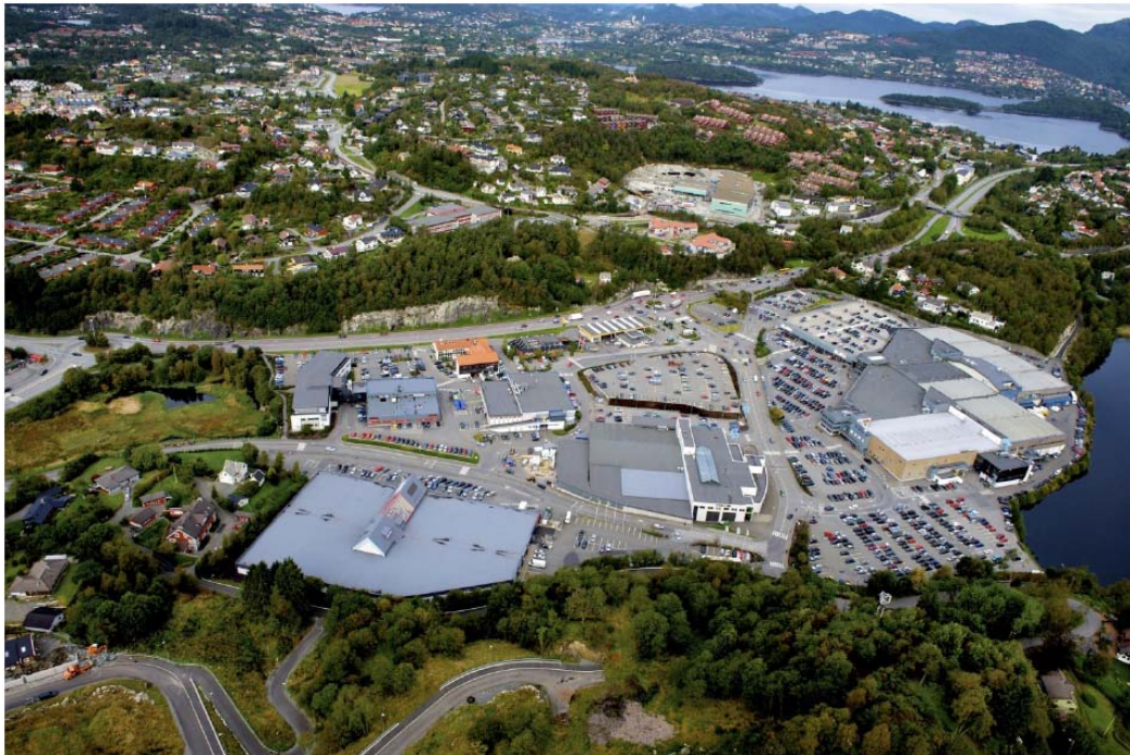
Figur 6.2.7.2 – Skråfoto av området sett fra øst
