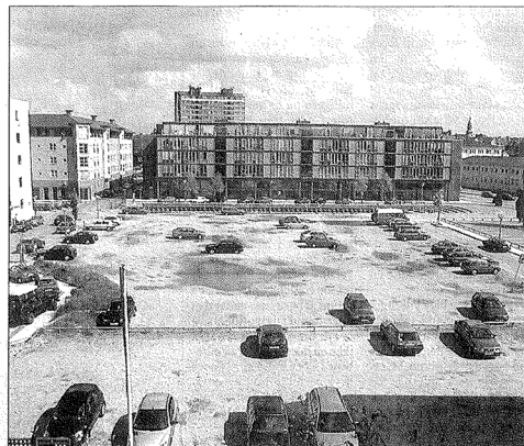
Kun et lille hængepart vedrørende 20 p-pladser skiller nu området mellem broerne fra at blive gjort til en længe ønsket bypark. AERINOTOTO
