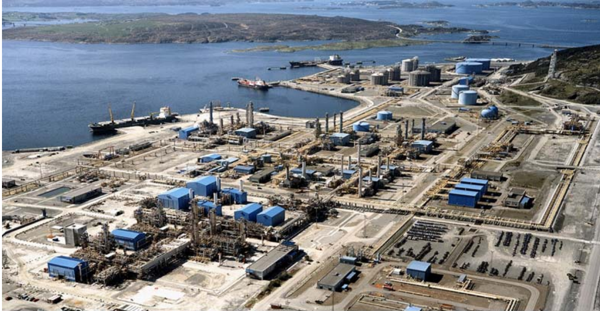
Figur 1 Kårstø prosesseringsanlegg (Statoil, Entry)
