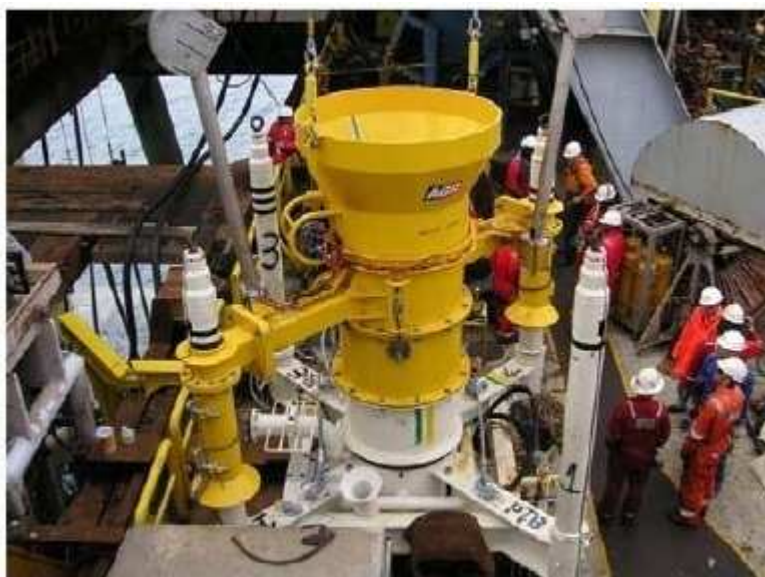
Bilde 6.1: wellhead Suction module[27].
