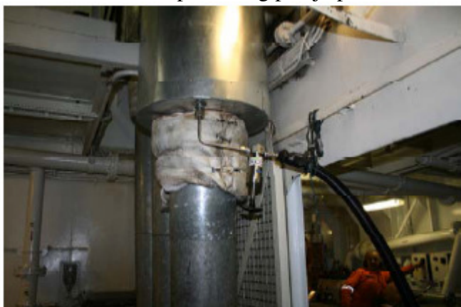
Bilde 8.4. Sondens plassering på hjelpemotor Scania D1 12 45 M [76].
