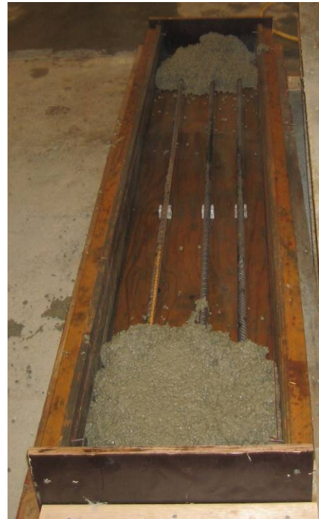
Figur 9 - Plate stripe under støping
