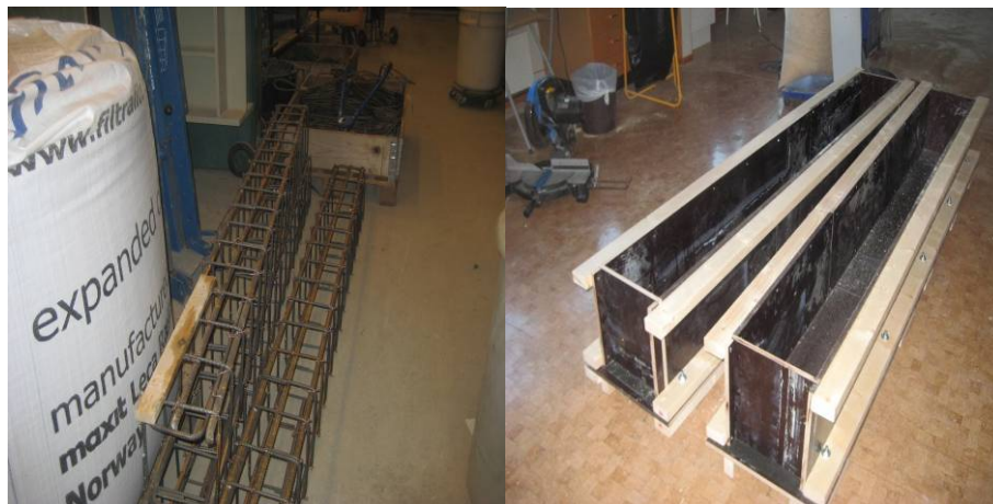
Figur 8 - Ferdig armerte bjelker og forskaling
