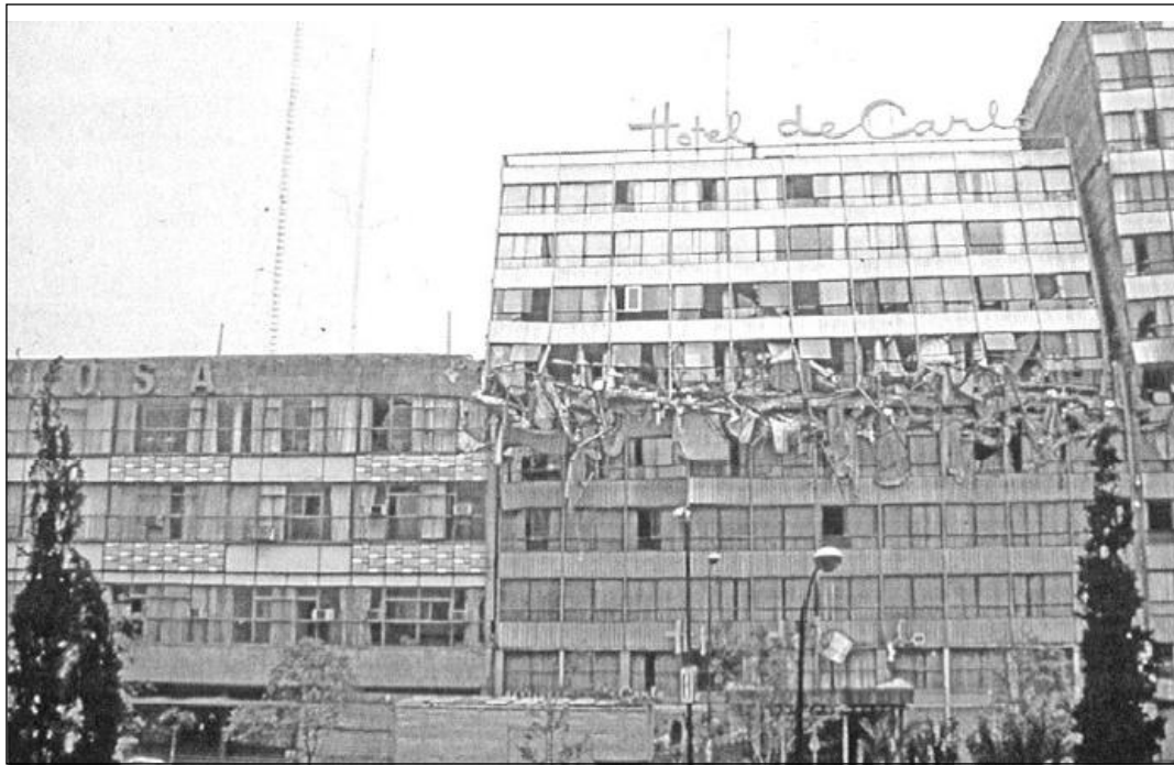
Figur 2.9 Kollaps av midterste etasje i et fleretasjes bygg i Mexico, 1985. [12]
