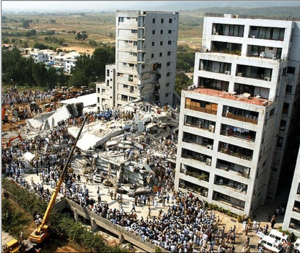
Figur 2.11 Totalkollaps av et bygg, mens et annet står urørt. [RIF kursmateriell, mars 2010]
