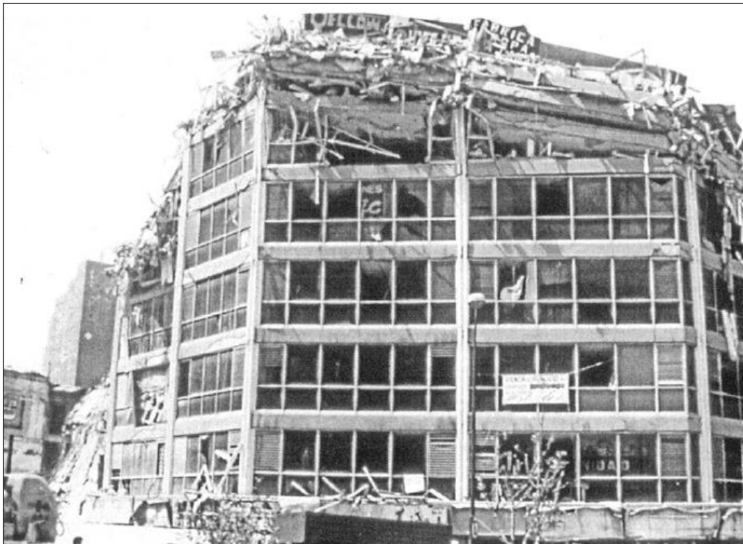
Figur 2.8 Kollaps av øverste etasje i en armert betongbygning i Mexico, 1985 [12]
