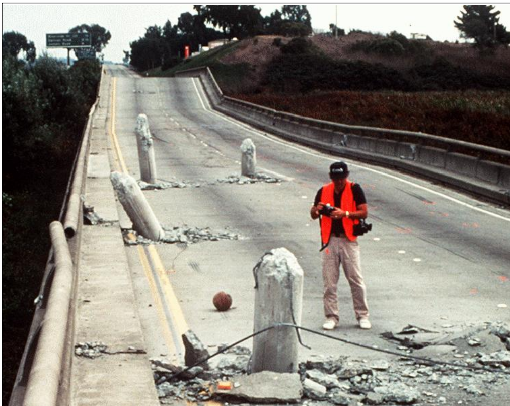
Figur 2.12 Kollaps av Struve Slough Bridge, California, 1989. [18]
