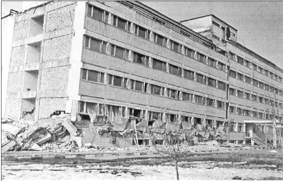
Figur 2.7 Kollaps av første etasje i en bygning i Tyrkia, 1992 [12]
