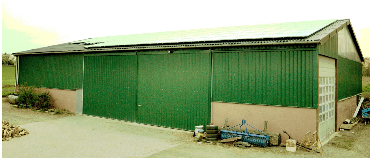
Illustrasjon 53: 30kWp Solcelleanlegg hos Harald Kotthaus
