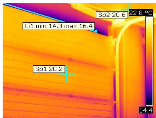
Illustrasjon 25: Innvendig varmefotografi av verkstadport
