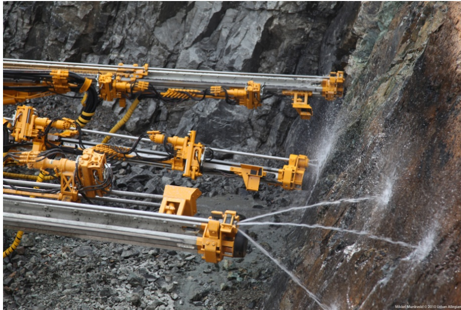
Figur 6 Enden på en borerigg under boring
