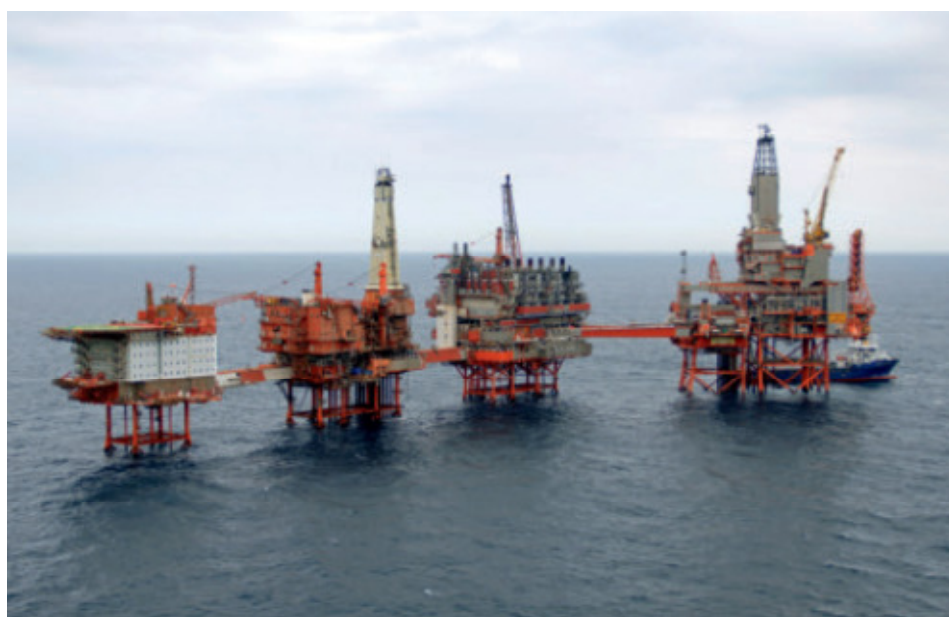
3.1 Valhall-senteret, f.v. Valhall QP, Valhall DP, Valhall PCP, Valhall WP og Valhall IP. Foto: BP Norge AS.
