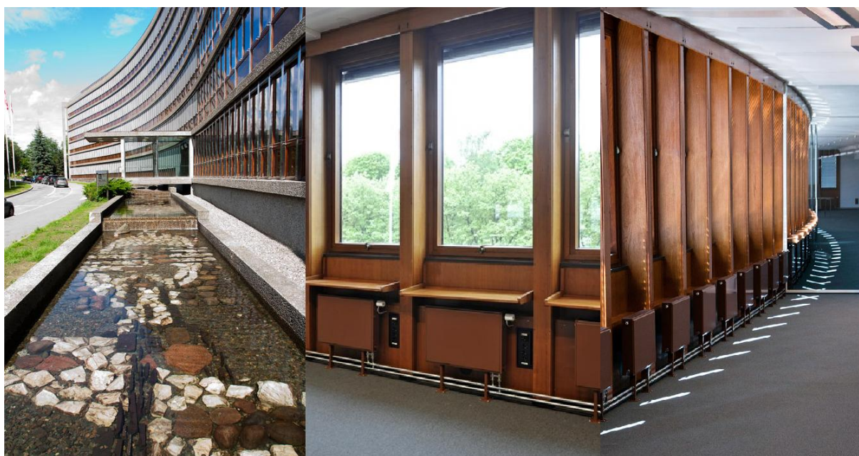
Figur 4. Innvendige og utvendige bilder av de buede fasadene til NVE-bygget. Ribbekonstruksjonen er fremtredene på fasadens innside og dekket med teakplater (Anda, 2012).
