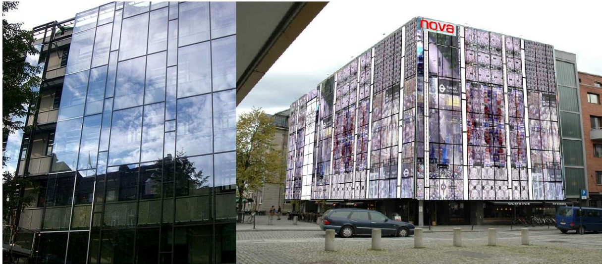
Figur 3. AØF Kongressenter i Trondheim. Bildet til venstre viser glassfasaden under oppføring (Kilnes, 2010). Bildet til høyre viser utkastet til den engelske kunstneren Stanza som vant byggets fasadeutsmykkingskonkurranse. På glassfasaden skal det fremvises samtidsdata som samles inn på forskjellige steder i byen (STANZA).
