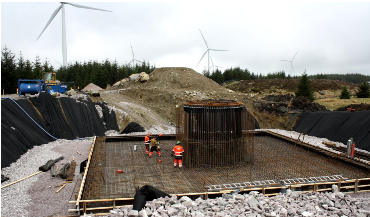
Figur 11: Fundament under oppføring i andre byggetrinn
