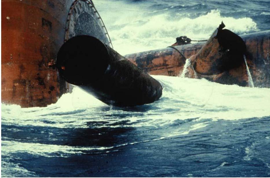
Figur 18: "Alexander L. Kielland"-ulykken, D-staget der tretthetsbruddet oppstod, fra [32] Foto: Norsk Oljemuseum
