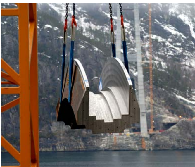
Figur 2-15: En tårnsadel à 13 tonn stål heises opp på tårnene på Hardangerbroa. (12)
