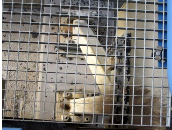
Figur 2-7: Bildet viser opplagrene i sør-enden, altså på Forsand-siden. (Gran, 2012)
