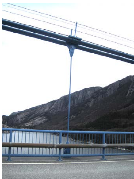
Figur 2-11: En av hengekablene på Lysefjordbroa. (Gran, 2012)
