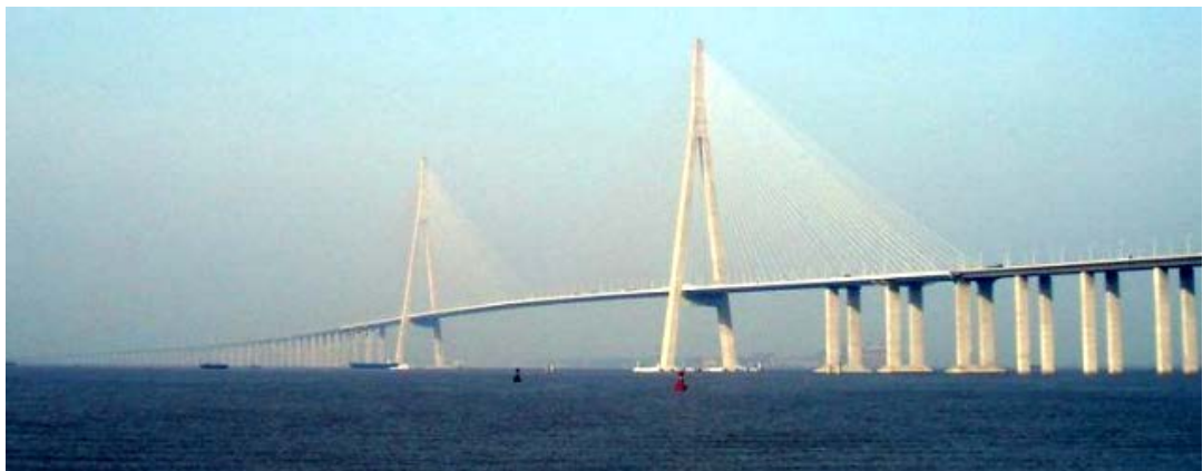
Figur 2-2: Verdens lengste skråstagsbro; Sutong bro i Kina med et hovedspenn på 1088 m. Åpnet i 2008. (5)(6)
