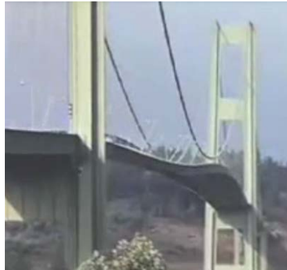
Figur 4-10: Torsjonssvingninger av Tacoma Narrows Bridge like før sammenbrudd. (30)
