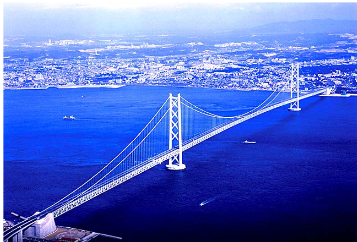
Figur 2-1: Verdens lengste hengebro; Akashi Kaikyo-broen i Japan med et hovedspenn på 1991 m. Åpnet i 1998. (4)
