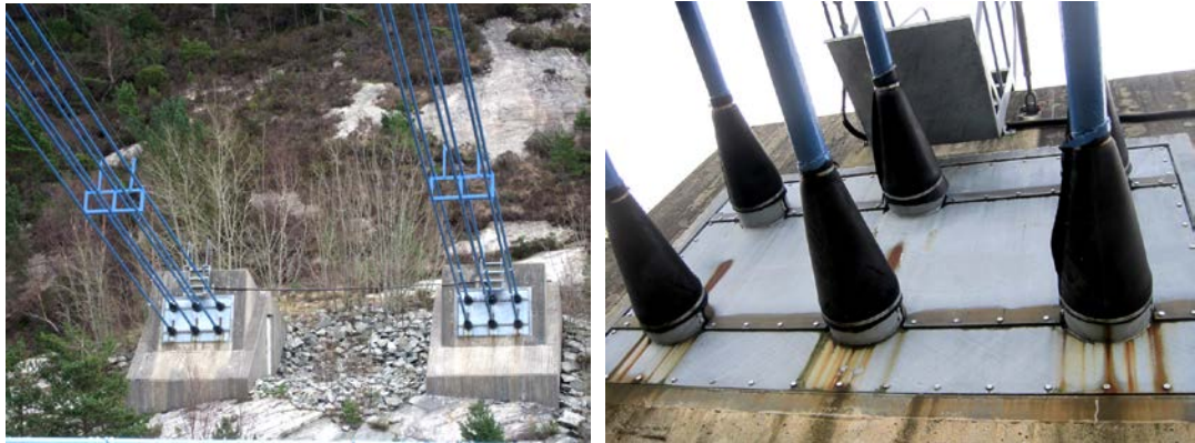
Figur 2-13: Ankerfestene på Forsand-siden. (Gran, 2012)
