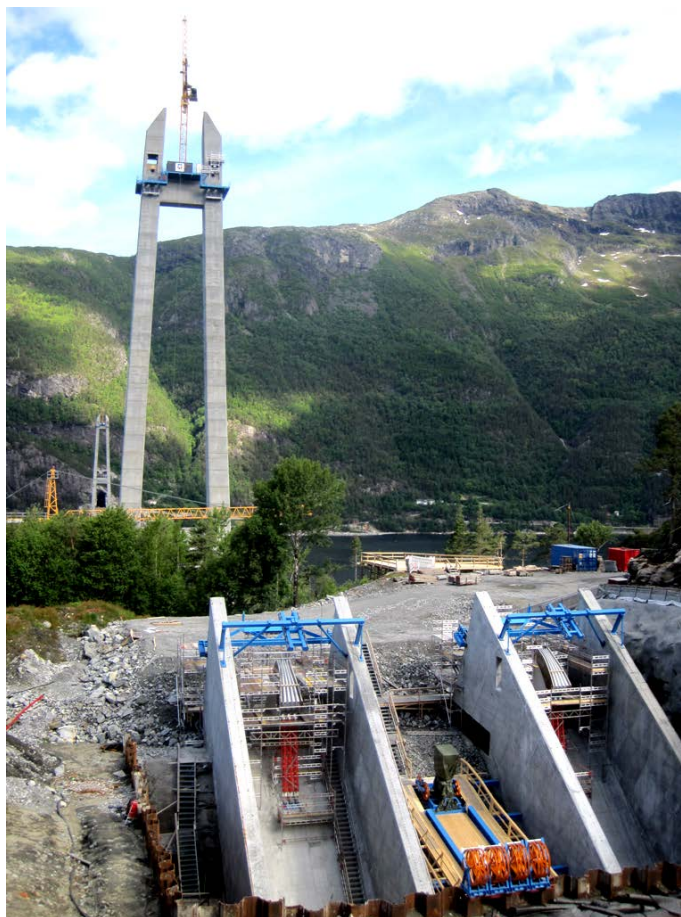
Figur 2-14: Spredkammere på Hardangerbroa (Gran, 2011).
