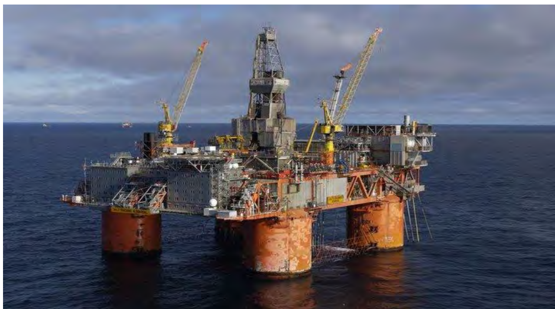
FABRIKASJON AV RØR, WP-41, TIE-IN 24A/B
