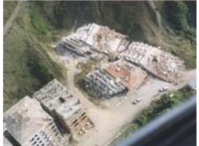
Figur 2.18. Kollaps av bygninger, jordskjelvet i Izmir, Tyrkia 1999, [9].
