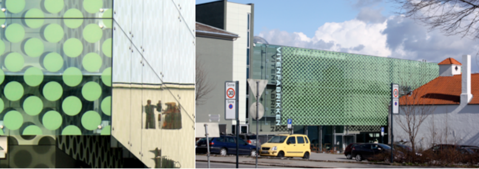
Figur 2.4.3 SILKETRYKK: Bildet til venstre viser det grønne, silketrykkede sirkelmønsteret i fasaden. Glassfronten er trukket ut fra veggens slik at sirkelmønsteret kaster skygger på betongflaten. Vi ser også hvordan Ståle Kyllingstads relieffer reflekteres i glassfasaden.
