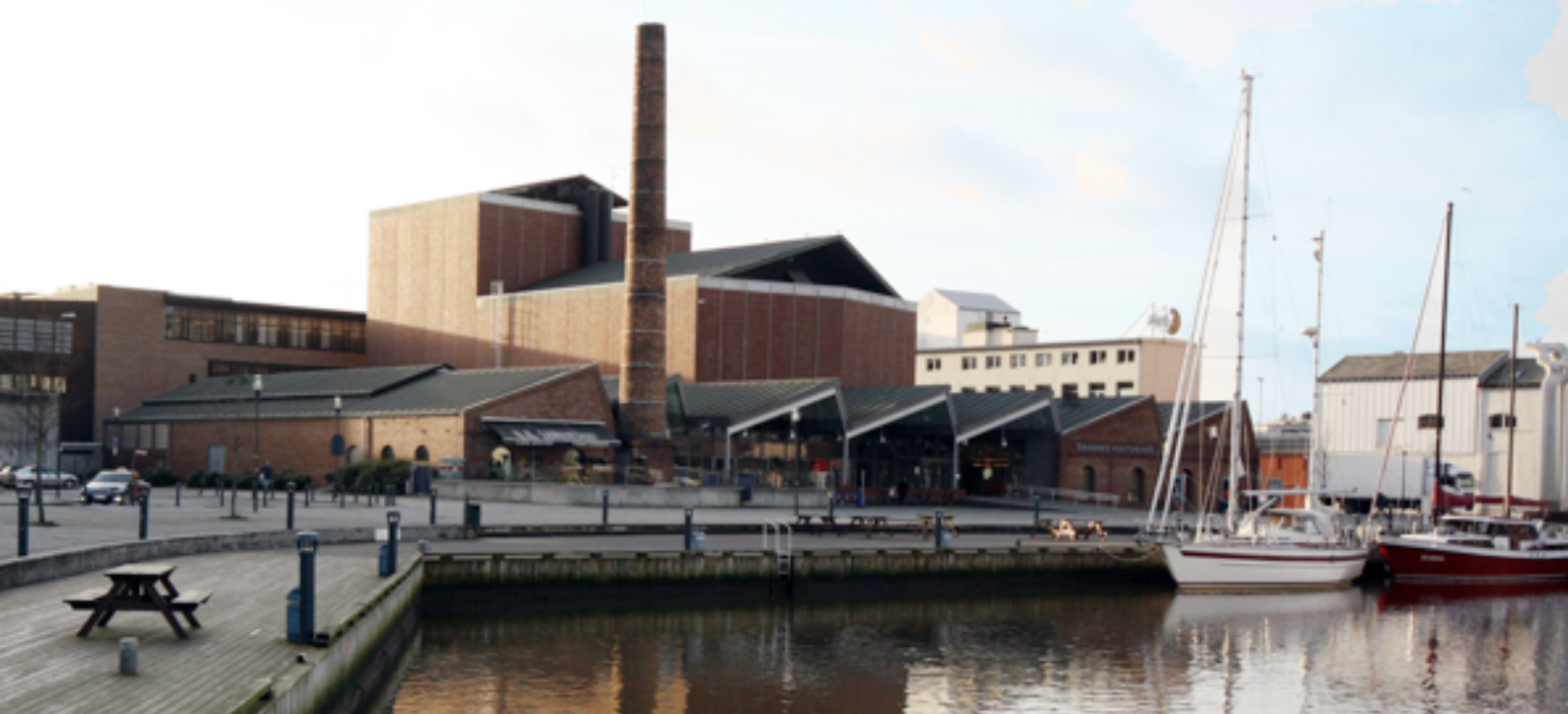
Figur 2.3.3 NÆRMILJØ: Bildet viser Sandnes kulturhus sett fra nord-øst.
