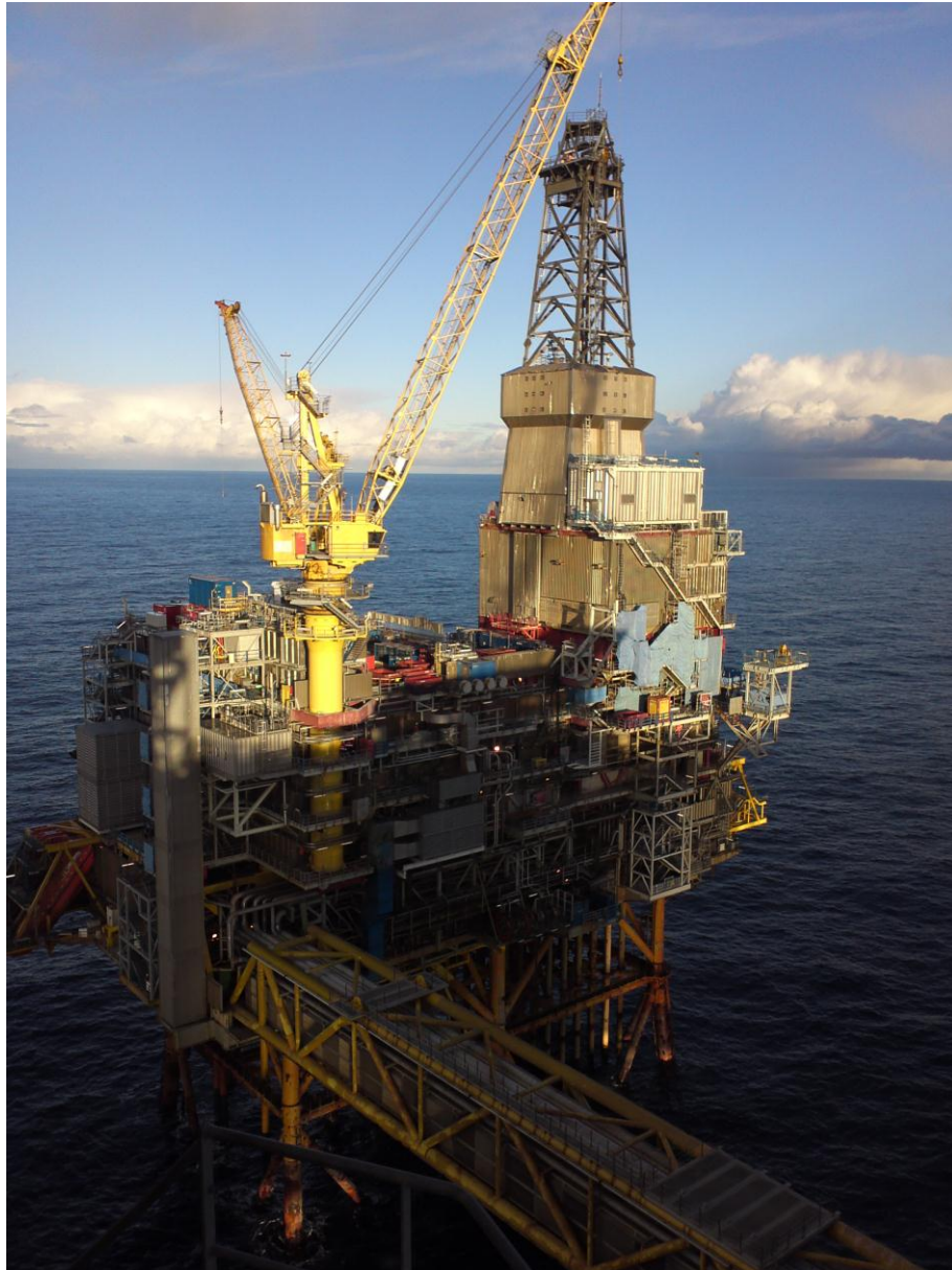
Foto Eirik Vaktal/Jan Ketil Moberg Statoil plattform, Oseberg B-2012
