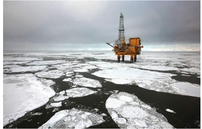
Figur 6 - Viser et eksempel på et område med drivis rundt innretningen (Klovning, 2013, s. 9).
