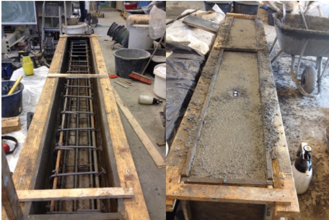
Figur 5.12 – Bjelke form med armering og ferdig utstøpt til høyre
