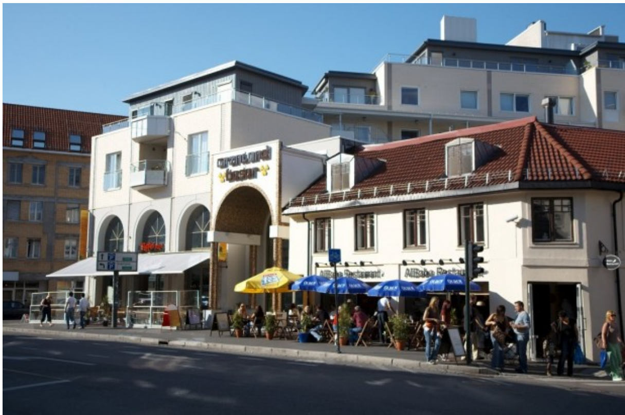
Figur 10 Bilde viser kombinasjonen av eksisterende og ny bygde bygnings struktur av Grønland Basar. Bilde: (Thorenfeldt 2006)
