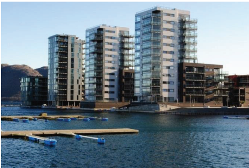
Nr. 2: Bilete nr. 2 er av ei modernistisk minimalistisk høgblokk, med 12 etasjar. Bygd i eit ombygd industriområde. Høgblokkene er i betong, glas og aluminium, frå ca. 2008. Høg prisklasse. Foto: Nils Jacobsen.
