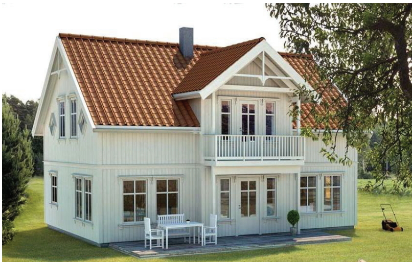
Nr. 6: Hus nr. 6 er ein frittliggjande bustad i tradisjonalistisk stil. Huset har 1 ½ etasje. Stilkopierende bruk av bygningsform, takark, karnapp og balkong. I tre med teglpanner. Frå ca. 2000. Kjelde: www.hellvikhus.no
