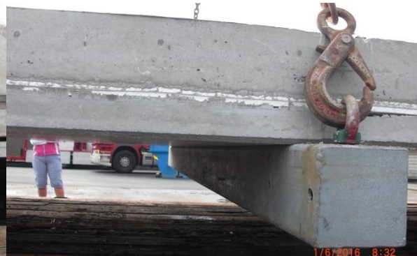
Vedleggsbilete 13 – Lasta blir påført ved å heise ned det fjerde opplegget
