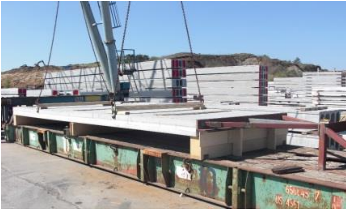
Bilete 9 – Plattformar kor elementa blei testa. Her blir eit 1250 element heist på plass
