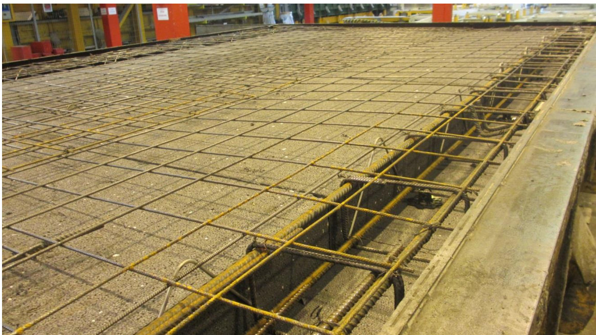
Bilete 1 – Typisk søylesone i eit element. Resten av innersjiktet er tynt.
