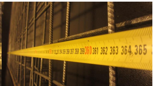
Vedleggsbilete 4 – Det var ca. 360cm frå kanten av elementet til overlappinga
