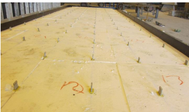
Vedleggsbilete 6 – Sjiktforbinderane blei jamt systematisk plassert. Alle står same vegen.
