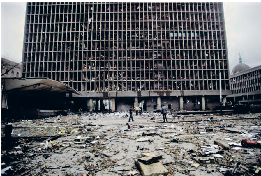
Figur 1: Høyblokka sett fra Einar Gerhardsens plass kort tid etter terrorangrepet 22/7.
