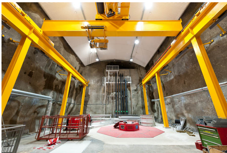
Figur 4.1: Maskinhallen i Jøssang kraftverk rett før ferdigstilling (Bygg.no, 2013)
