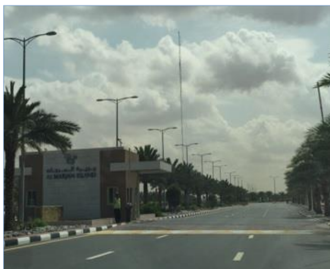
Figur 37 Inngang til Breeze Island og AMI (ref. eget bilde)
