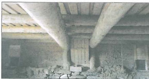
Møkkakjelleren under fjøset har solid konstruksjon av svære tømmerstokker. Dette fjøset kunne stått 100 år til.
