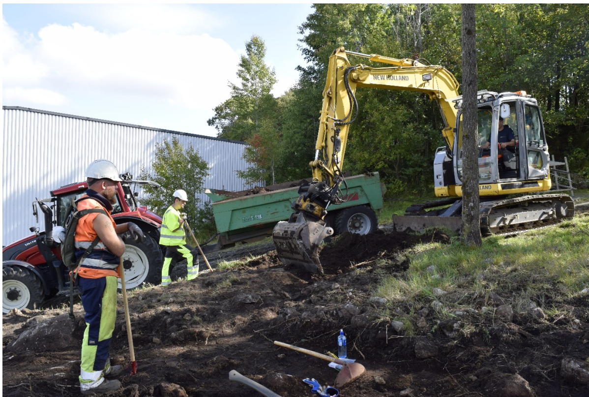
Figur 6: Arbeidsbilder med Jon Reinhardt Husvegg, Tomasz Galewski og maskinfører Torfinn Nygård
