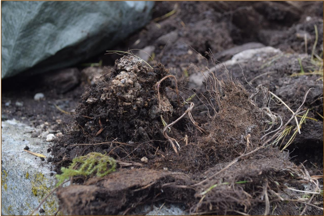
Figur 15: Gresset som hadde vokst rett på kalken i morkjernen. Rotsystemet hadde smuldret opp noe av mørtelen.
