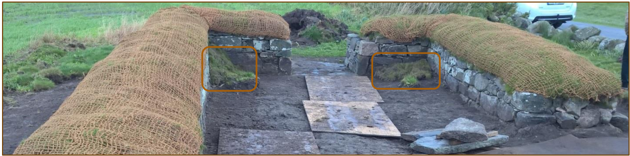
Figur 35: Områdene med kalkpuss etter behandling.
