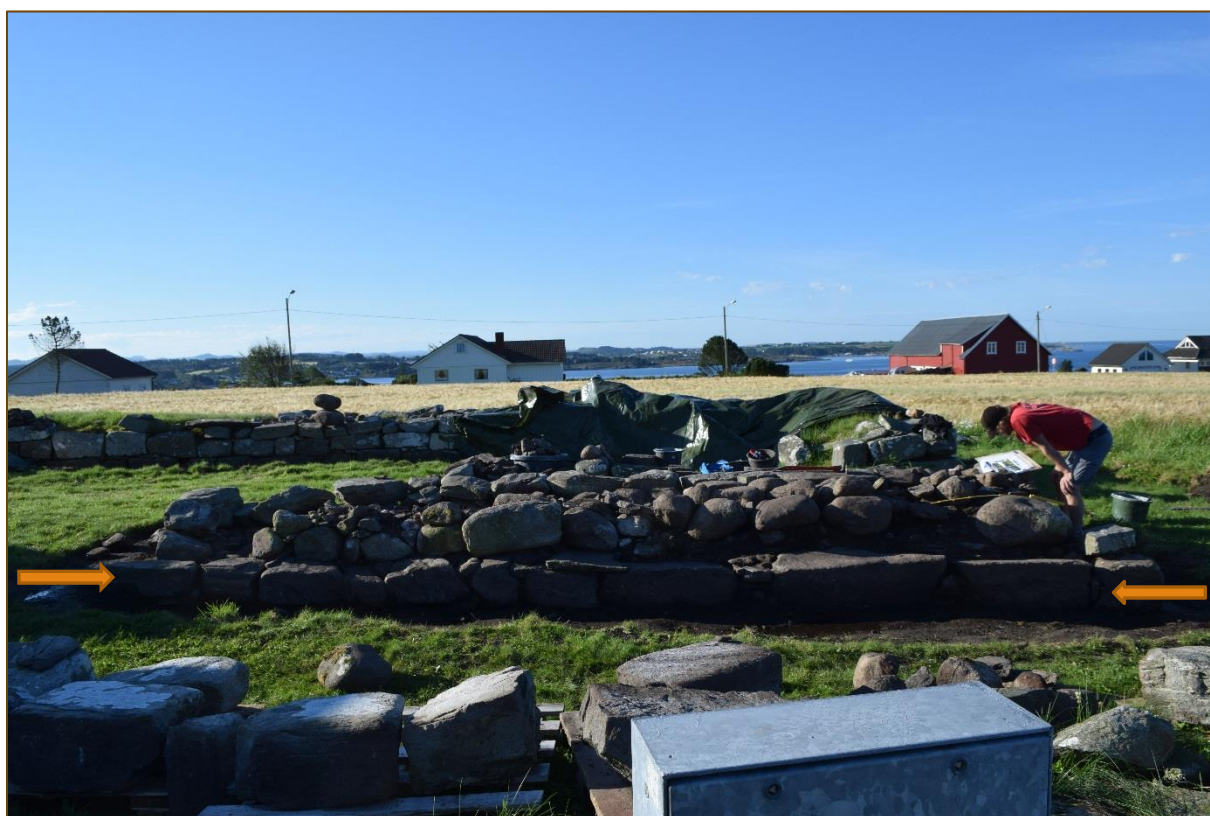
Figur 19: Nordveggen, bildet er tatt mot sør. Torvlaget fjernet inntil murvanger, og det nedre skiftet (se pilene) ble avdekket. Murkjernen er blitt rensket for torv og jord. Det øverste skiftet av murverket er blitt demontert og ligger på paller i forgrunnen av bildet. George Murphy sjekker bilder av tidligere utseende før remonteringsarbeidet.
