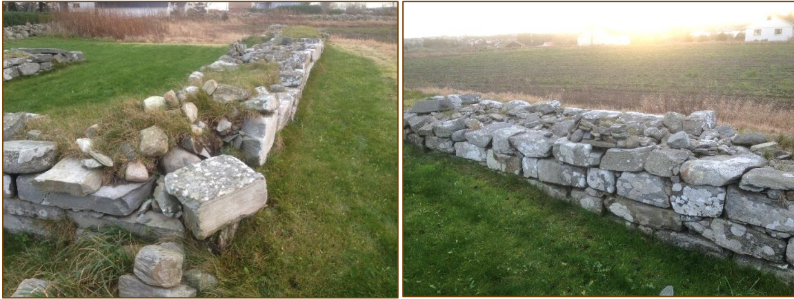
Figur 10(a): Ytre vangen av det sydvestlige hjørnet. Kollaps har ført til at murkjernen ble eksponert og uten støtte (b): Indrevangen av sørveggen. Murverket var i relativt god og solid stand.
