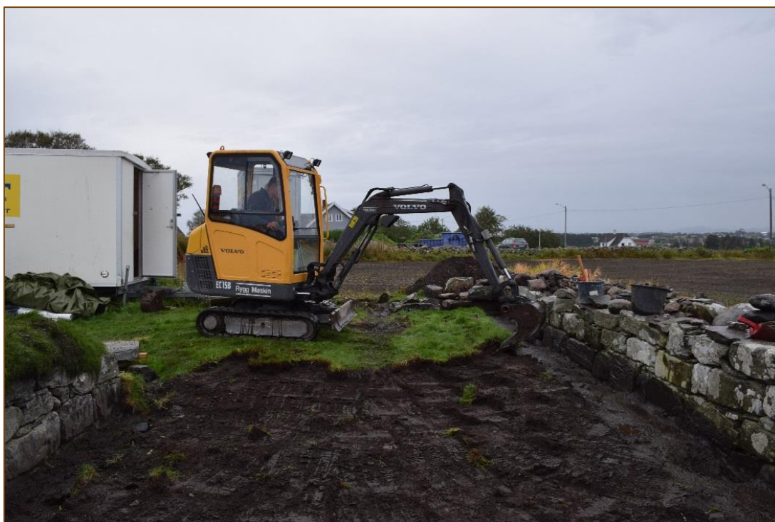
Figur 28: Fjerning av torvlaget i kirkerommet.
