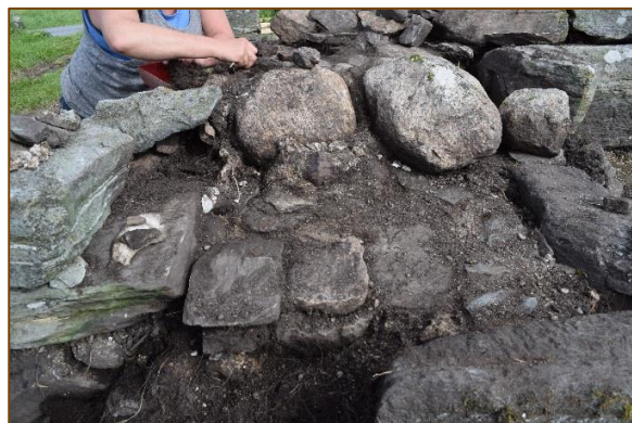
Figur 18 (a): Nordvestre hjørne, fjerning av jord fra murkjernen (b) kalkbundet murkjerne kommer frem under rensarbeidet.
