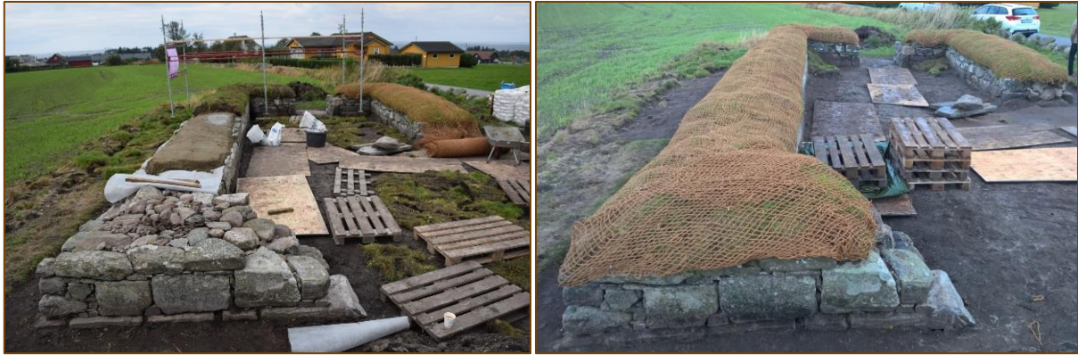
Figur 33(a): Oversikt over ruinområdet mens toppdekkarbeidet ble utført. Bildet viser alle trinn av oppgaven (b): Oversikt over ruinområdet etter at toppdekkarbeidet var gjennomført. Biologisk nedbrytbar netting er festet over torven.
