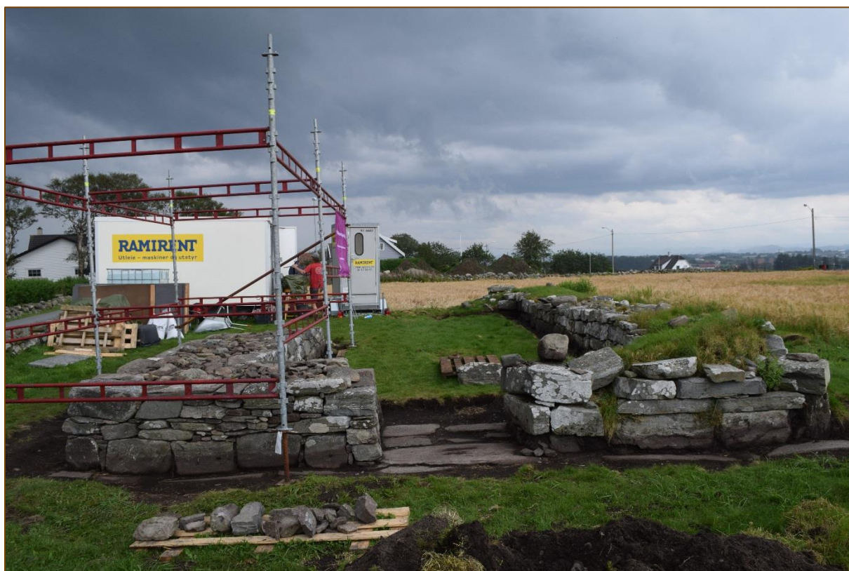
Figur 23: Arbeidet på vestveggen ble gjennomført i to faser. Nordveggen og nordvestre hjørne sammen med nordre del av vestvegg (t.v. for inngangen) var restaurert ferdig før sørveggen sammen med søndre del av vestvegg (t.h. for inngangen) og østvegg ble restaurert.
