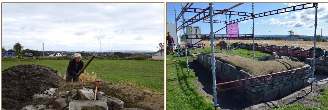
Figur 30(a): Østvegg, komprimering av bentonitt-leireblanding ved å slå på den (b): ferdig lagt bentonitt-leireblanding med svak konveks form.
