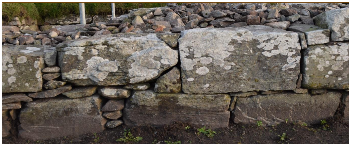
Figur 26: Stabilisering av sørveggen ved pinnesteiner. Kun pinnestein med naturlige overflater ble brukt.
