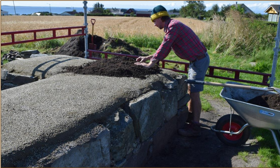
Figur 31: Nordvestre hjørnet, legging av jordlag på et enkelt lag av grus.
