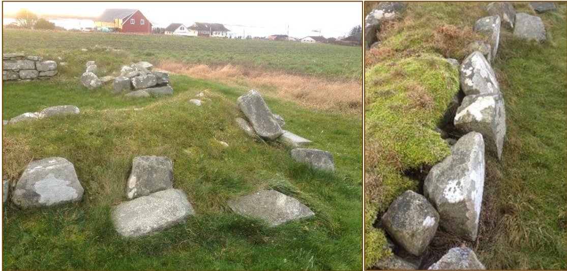
Figur 8(a): Ytrevangen av nordvegg, nordvestre hjørnet har kollapset (b): Ytrevangen av nordvegg, med steiner som stod på høykant på en svært ujevn linje. Nedre skift av murverket er gjemt av torv.
