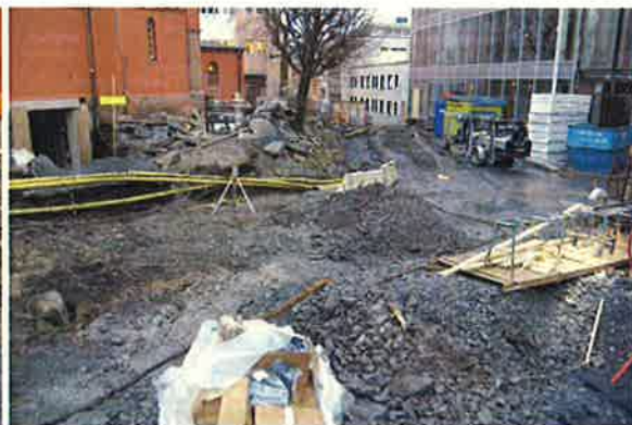
Figur 3 NV-del av platået. Mot VNV.
