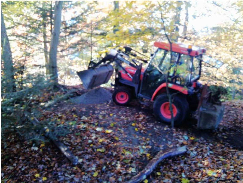
Figur 8 - Bruk av minitraktor til transport av fyllmasser
