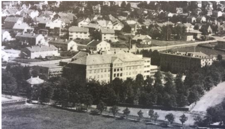
Rogaland sjukehus, 1964 eller 1965. Bak hovedbygningen kan man skimte «Østbygget» fra 1963 (Stavanger Universitetssjukehus & Helse Stavanger HF, 2007).
