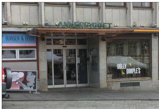
Figur 2.48: En takflate ved inngangen til Ankerkvartalet, som gir mulighet til å søke ly for nedbør.
