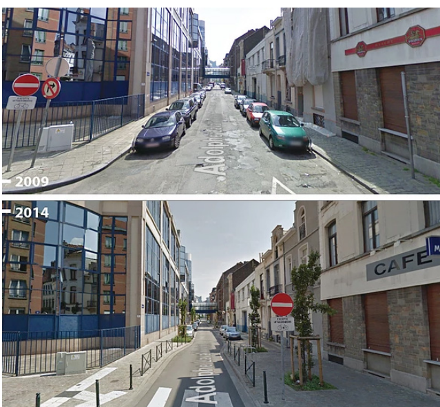
Figur 3.11 Utvidelse av fortau i Adolphe Lavalléestraat i Brussel, Belgia. Kilde: Urb-i
