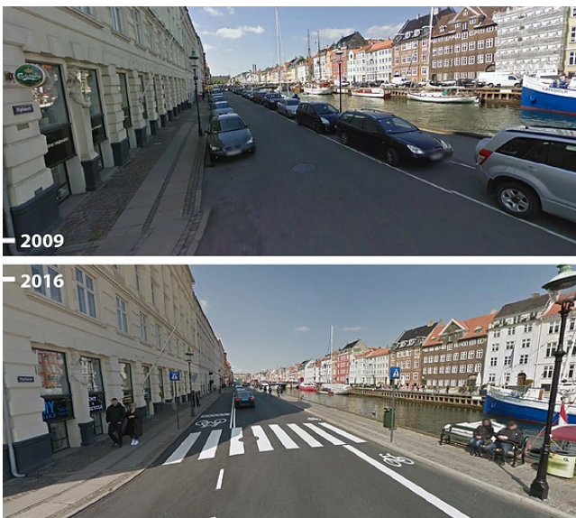
Figur 3.15 Fjernet gateparkering til fordel for sykklistere, Nyhavn. Kilde: Urb-i
