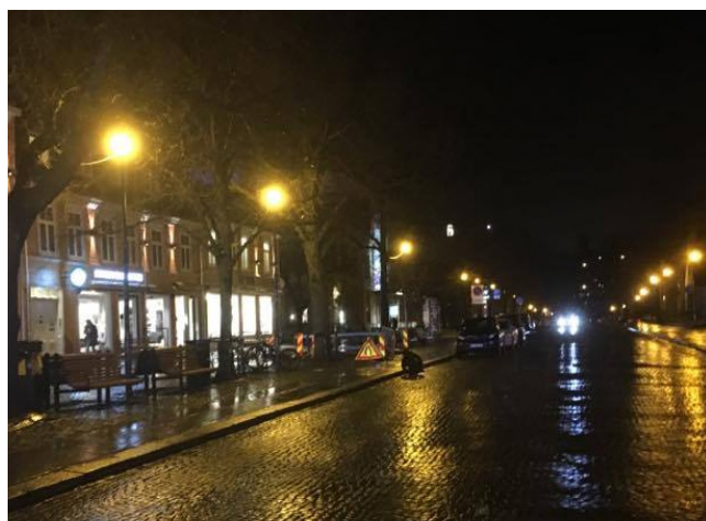
Figur 4.31 Trollaarmatur i Kongens gate
