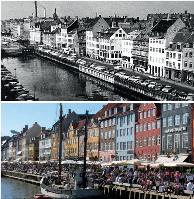
Figur 3.5 Omdisponering av gateparkering til kafeer og uteservering i Nyhavna, Danmark. Kilde: Urb-i
