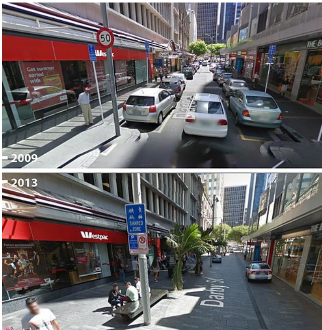
Figur 3.18 Fra gateparkering til shared space i Darby St. i Auckland, New Zealand. Kilde: Urb-i
