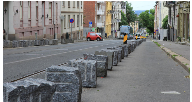
Figur 3.10 Fjerning av gateparkering i Thereses gate, Oslo
