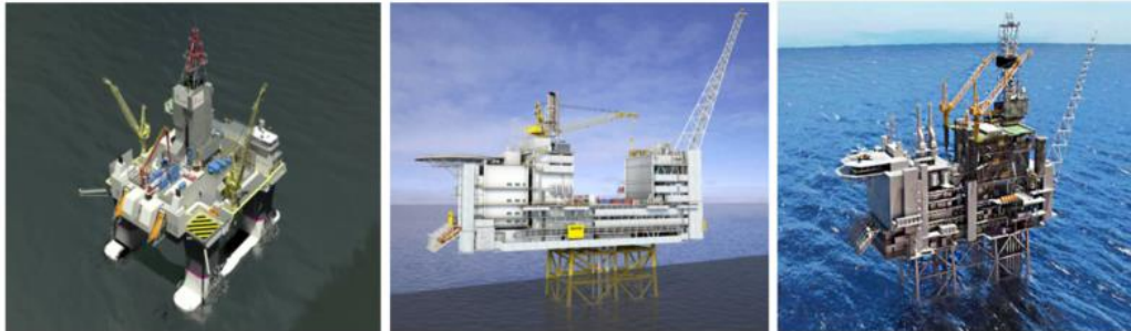
(a) CAT-D rig (Dagens Næringsliv, 2012)
