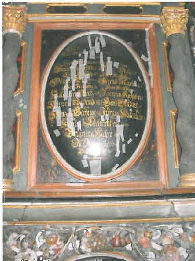
Foto 3: Detalj av hovedfelt etter forsidesikring
