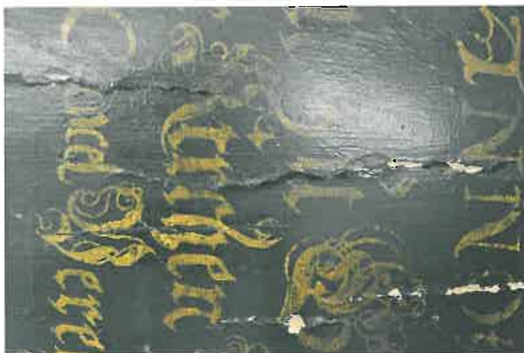
Foto 42: Detalj av takformede oppskallinger på hovedfeltet
