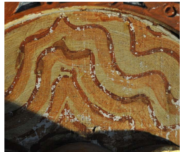
Fig. 15) Detalj av felt nr. 1, marmorert fylling etter konsolidering
