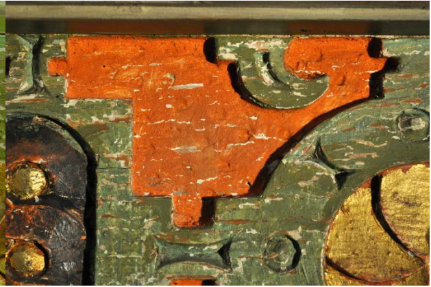
Fig. 13) Detalj av felt nr. 1 etter punktkonsolidering med størlim
