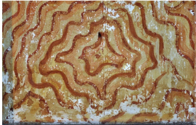
Fig. 11) Store områder med tap av maling som eksponerer den hvite grunderingen.
