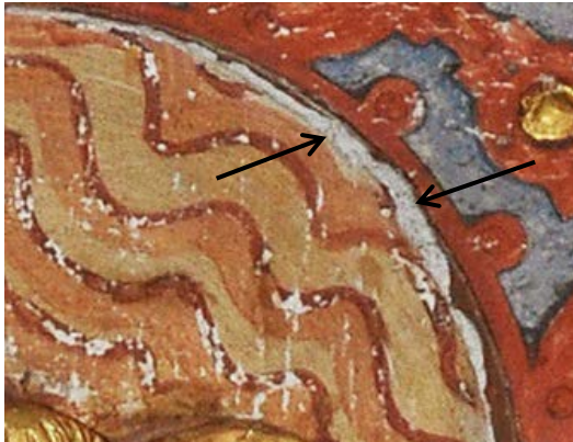
Fig. 10) Treverket har krympet og hvit grundering på marmoreringsfeltet som opprinnelig var ment å være tildekket av buen, er nå synlig.
