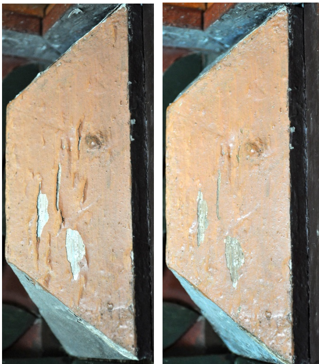
Fig. 23 og 24. Oppskallinger på diamantkloss før og etter konsolidering.
