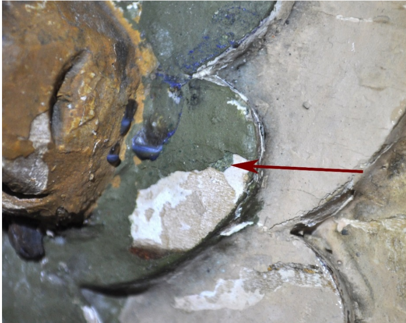
Fig. 14: Spor etter original grønmaling kommer frem i skadeområder i vinge på engel.
