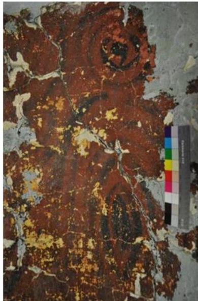
Fig. 64. Detalj av det som antas å være en grov treimitasjon fra ca 60 cm over gulv og videre opp.
