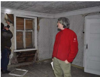
Fig. 12. Rom 204. Sørvestre del av rommet slik det så ut ved befaring i 2010.
