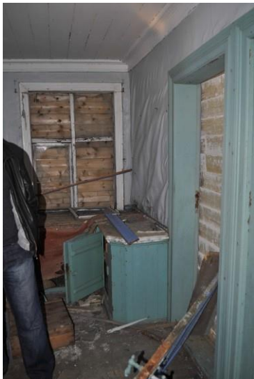
Fig. 8. Rom 202, Kjøkken 2, sett mot sørvest slik det så ut i 2010.
