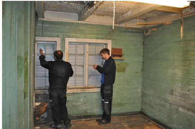
Fig. 4. Under arbeid i 2013. Rommets vestre del med vindu og vegg til avlukke B.
