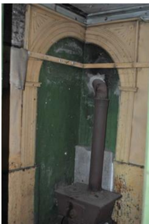
Fig. 17. Rom 206. Sørvestre hjørne med brannmur og ovn i 2011.
