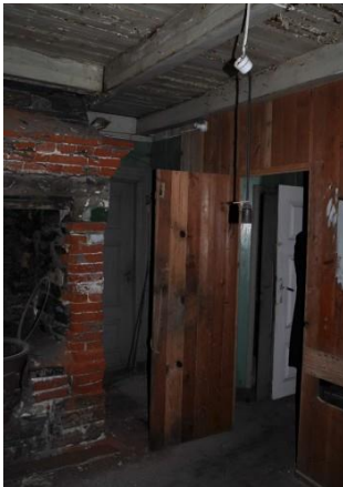
Fig. 3. Fra befaring i 2010. En lettvegg mot sør var da i rommet. Fjernet.
