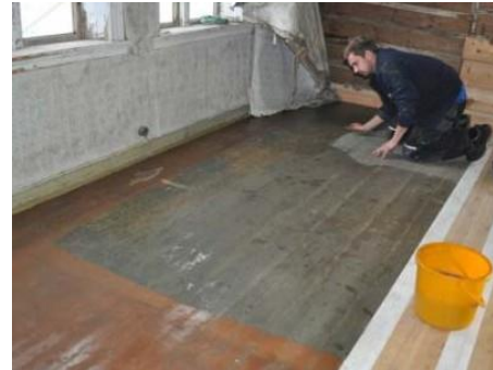
Fig. 57. Alle de fire lag er synlige på dagens gulv etter grundig vasking av overflate. (Snekker Rune Johnsen i sving med vaskebøtta.)
