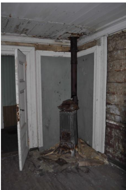
Fig. 10. Rom 203. Nordøstre hjørne slik det så ut i 2010. Tapetlagene fjernet på østvegg.
