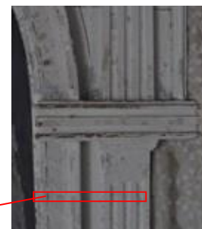
Fig. 55. Detalj av brannmurslist hvor profil er tatt.
