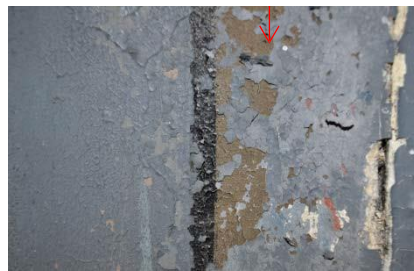
Fig. 52. Detalj ytterkant brannmur, lag 2-5.
