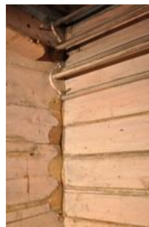
Fig. 23. Avlukke B. detalj av dagens vegg med negative spor etter hyller.
