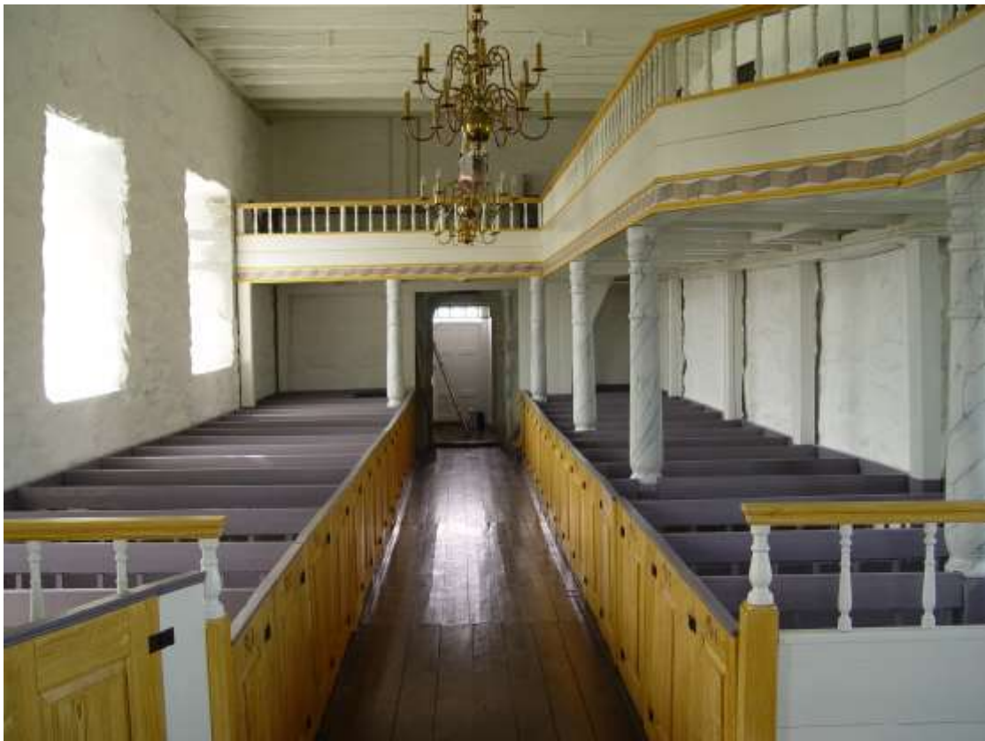
Fig.35. Kirkerommet sett mot vest etter restaurering/tilbakeføring til 1864.
