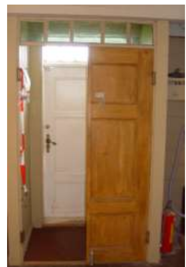
Fig. 33. Vindfanget sett mot vest. Svingdøren (halvdelen) med ådring. Vinduet over den hvite ytterdøren er fra periode 3.
