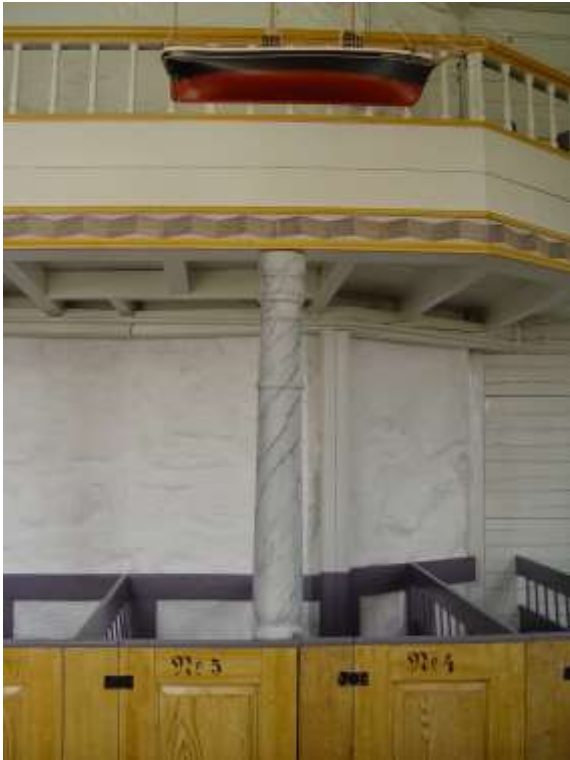
Fig. 36. Detalj av nordøstre del av skip/galleri etter ny fargesetting. (Fig. 5 viser tilsvarende område før restaurering.)
