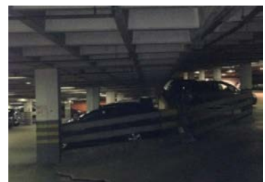
Figur 11: Bildet illustrerer overgang mellom etasjene (2015). Foto: prosjektgruppen
