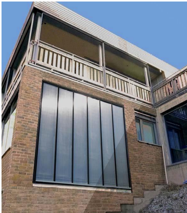
Figur 10 Flat solfanger integrert i fasaden
