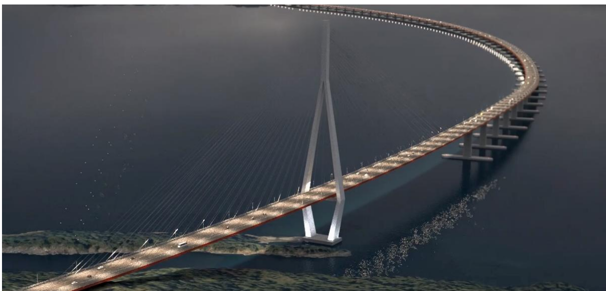
Figur 4.3: K7 - Endeforankret flytebru. Illustrasjon hentet fra Statens vegvesen (2018).
