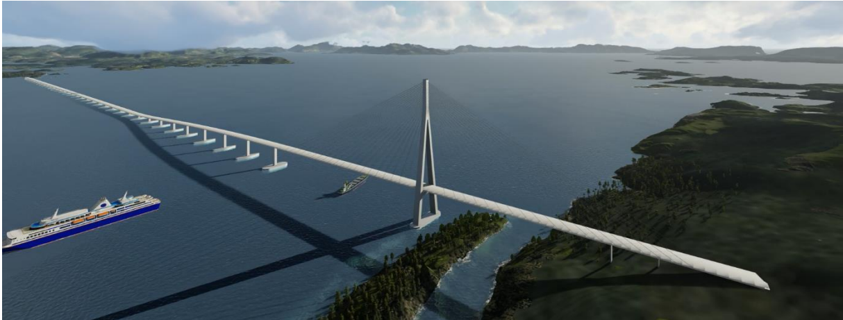
Figur 4.4: K8 - Sideforankret flytebru. Illustrasjon hentet fra Statens vegvesen (2018).
