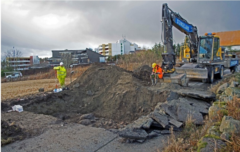
Figur 113 Fra utgravningen av sjakt i Sundeveien. Mot VNV.
