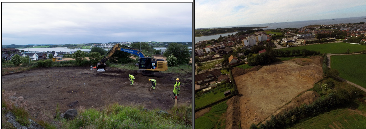
Figur 11 Maskinell flateavdekking pågår på Felt 3. Mot SV. Figur 12 Felt 2 for utvidelse av feltet mot S og N. Mot NV.
