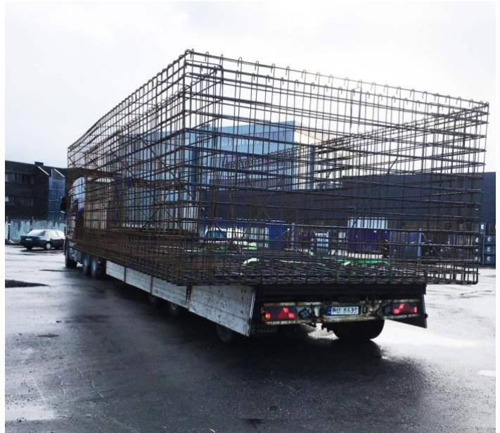
Figur 5 – Prefabrikkert armeringselement (Kamstål, u.å.)
